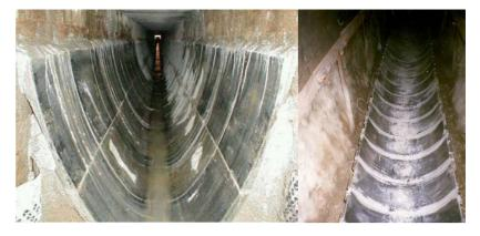
werden beiderseitige längliche Stahlträger verwendet, gestützt mit kurzen Stahlstielen in Kombination mit dem Ankerausbau, dessen längliche Träger im umliegenden Gestein verankert sind. Nach der Vornahme solcher Maßnahmen können die Bauarbeiten erst fortgeführt werden.
